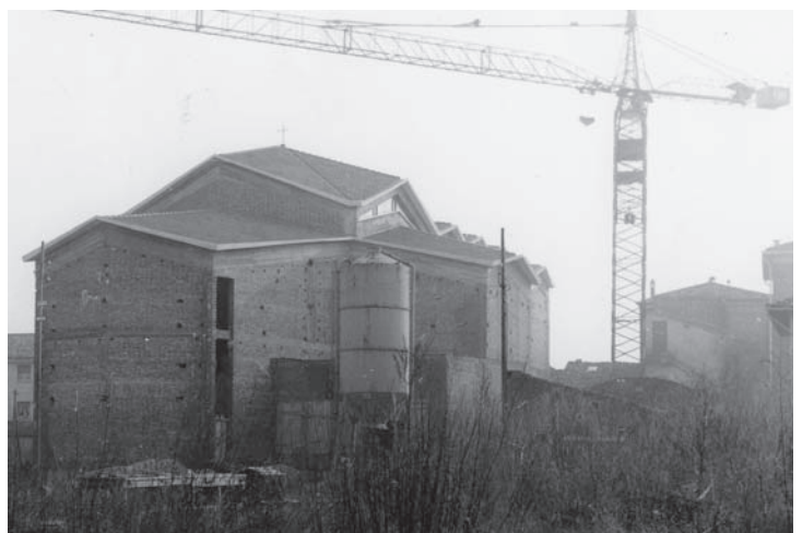
Scorcio della chiesa in costruzione
